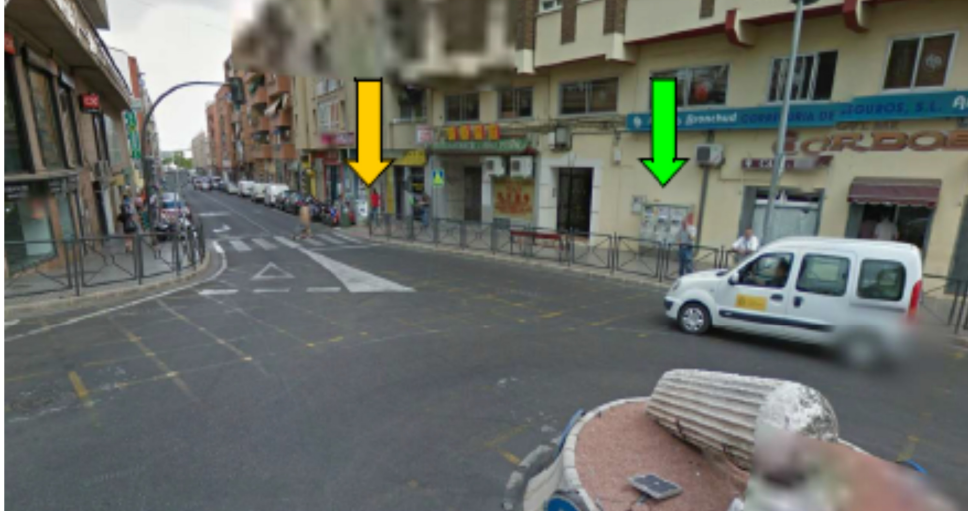
Regulador (Sin servicio) y Equipo de medida. Cuadro Alumbrado Público N.º 157
