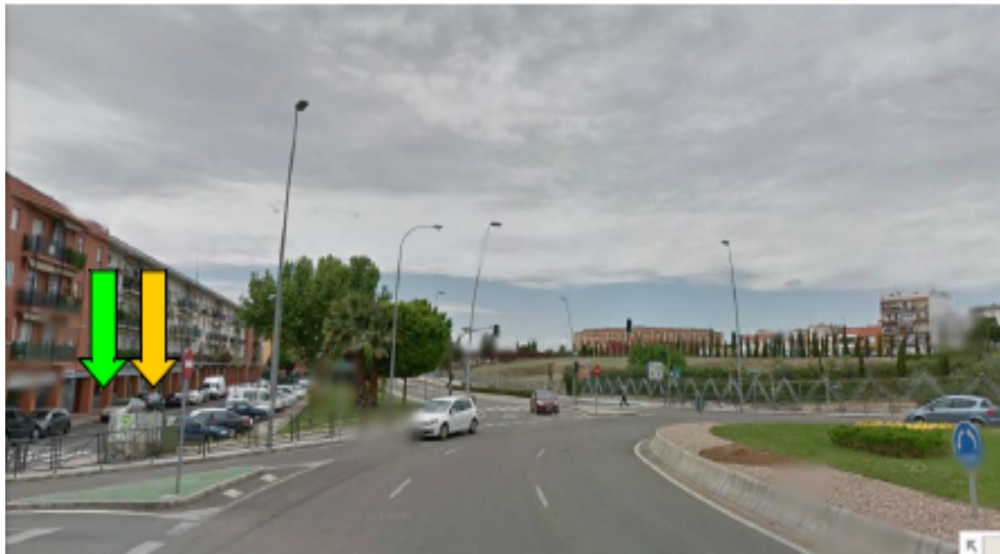
Regulador y Equipo de medida. Cuadro Alumbrado Público Nº 66
