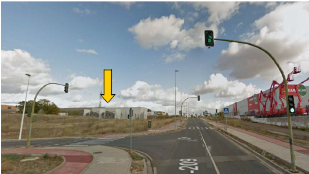
Regulador y Equipo de medida. Contador (Edificio Policía)
