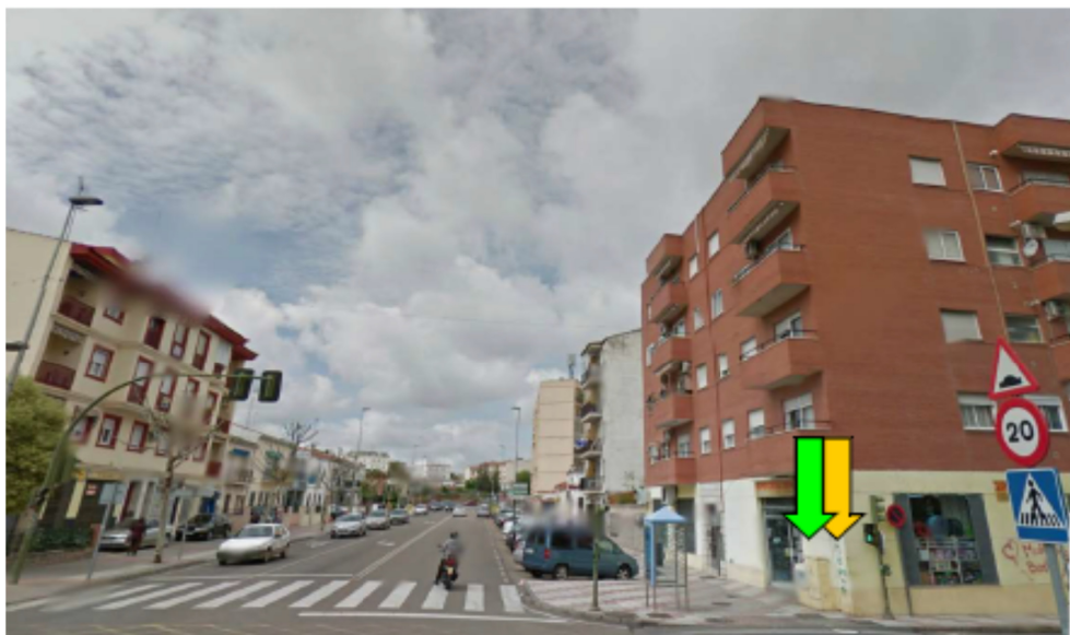
Regulador y equipo de medida. Nº contador: 3060
