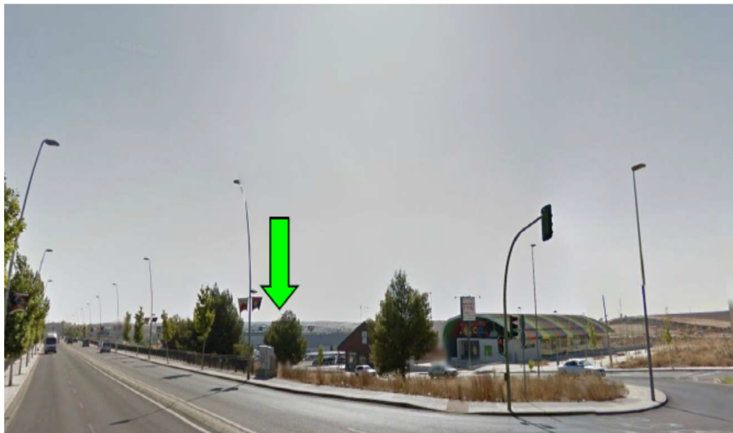
Cruce acceso a La Heredad - Equipo de medida para R-1, R-2 y R-3 Cuadro Alumbrado Público Nº 175
