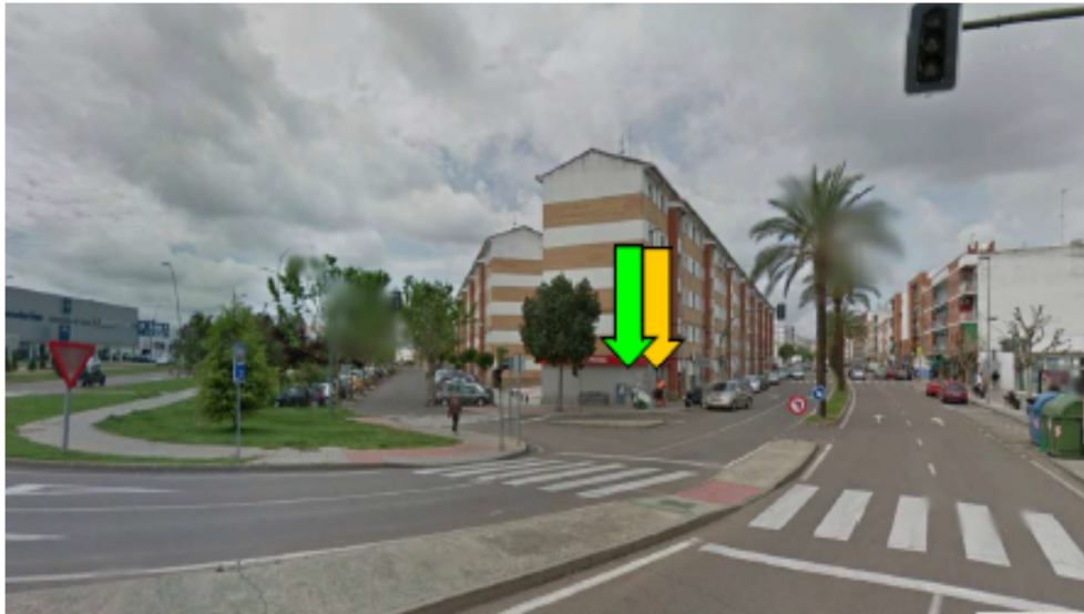
Regulador ( Sin servicio ) y equipo de medida. N.º Contador: 20194746
