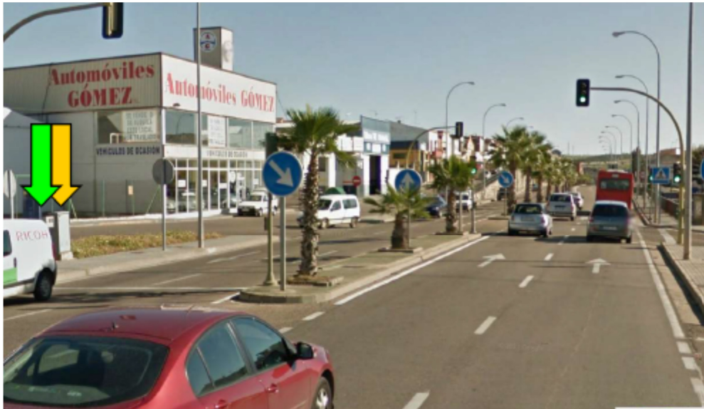
Regulador y Equipo de medida. N.º Contador: 3058
